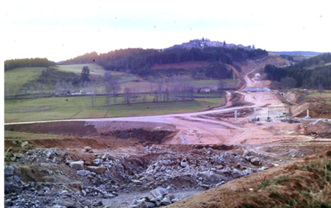
Chantier coté Ouest vu depuis La Cure – décembre 1981
