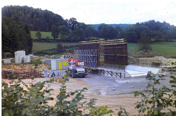
Construction du Pont de Beurière – Octobre 1981
