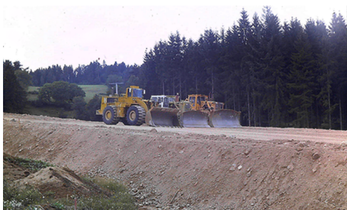
Terrassements à Beurière - novembre 1981
