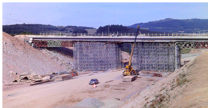
Construction du Pont de La Cure - juillet 1982
