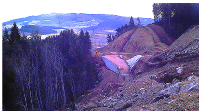
Construction du mur de Bareille – décembre 1981
