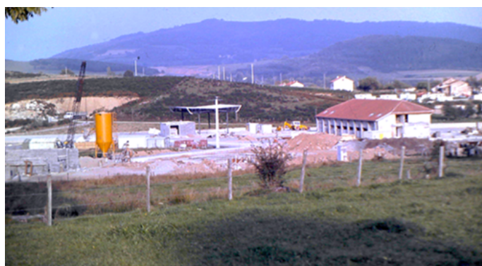
Construction du Péage – septembre 1983
