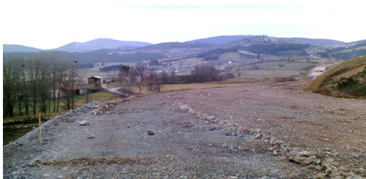
Le chantier au niveau de Mérange – décembre 1981
