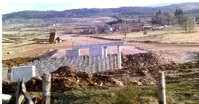
Construction de l'échangeur- Mars 1982
