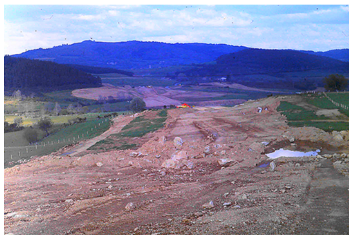
Le chantier coté Est vu depuis La Cure – juillet 1981
